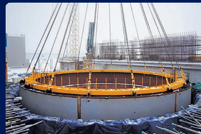
Монтаж реакторной установки четвертого поколения БРЕСТ-ОД-300 в Северске. Источник: Росатом
